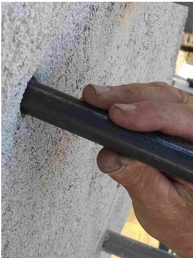
A falon 10 cm vastag hőszigetelés van, ezért távtartóként vascső darabokat építettünk be.
