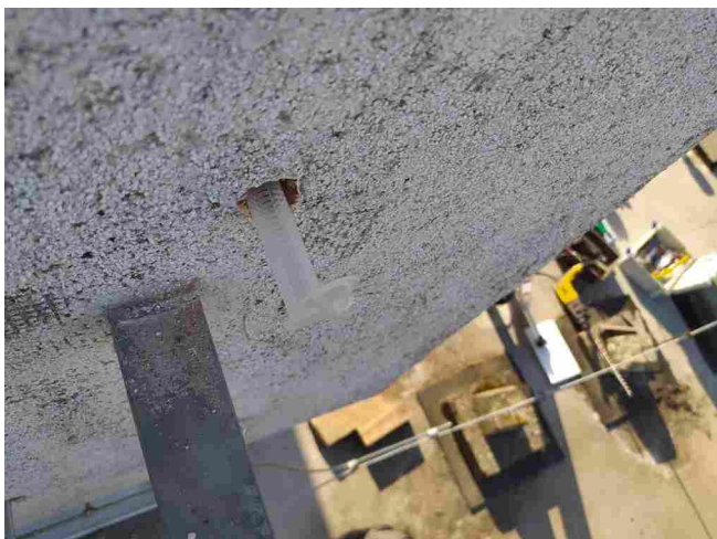
A blokktéglába a ragasztáshoz műanyag kosarat alkalmaztunk.
